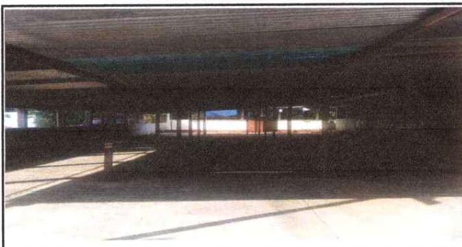
Foto 5: ESTRUCTURA DE TECHO: Sustitución de estructura de soporte de madera, por metal.
