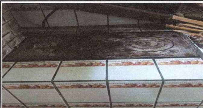
Foto 2: MÓDULO 1 COCINA: REPARACIÓN DE COCINA: Sustitución de plancha de metal de 3 hornillas
