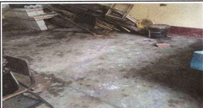
Foto 1: MÓDULO 1 COCINA: PISO: Reparación de piso de torta de concreto
