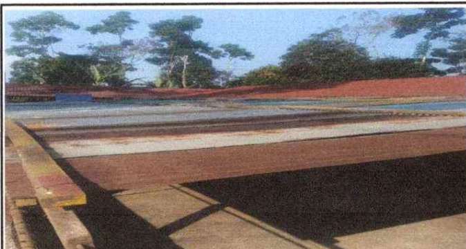
Foto 3: MÓDULO 2 CANCHA: CUBIERTA DE LÁMINA: Sustitución de lámina, por lámina troquelada aluzinc calibre 26, Sustitución de capote de lámina para lámina troquelada
