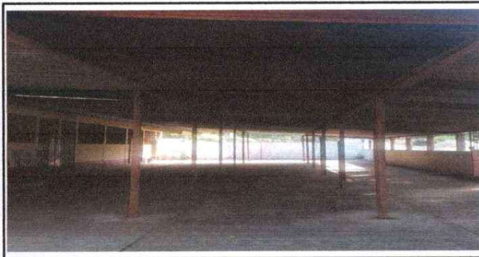
Foto 6: ESTRUCTURA DE TECHO: Sustitución de estructura de soporte de madera, por metal.
