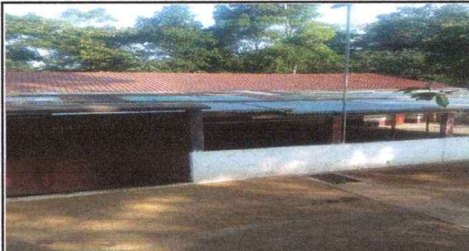
Foto 4: MÓDULO 2 CANCHA: CUBIERTA DE LÁMINA: Sustitución de lámina, por lámina troquelada aluzinc calibre 26, Sustitución de capote de lámina para lámina troquelada
